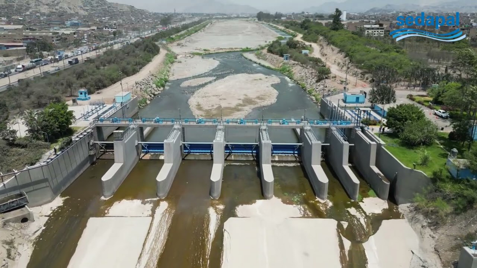
Planta de tratamiento de agua, La Atarjea
